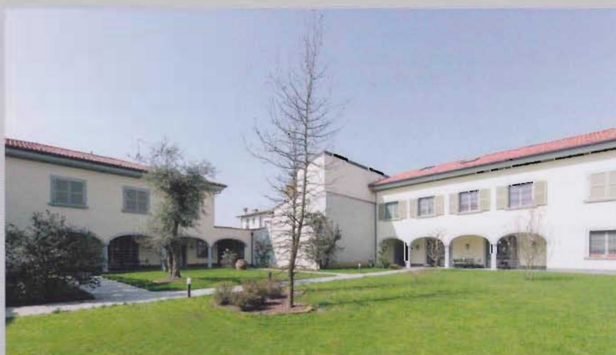
Immagini esterne delle due abitazioni ristrutturate
